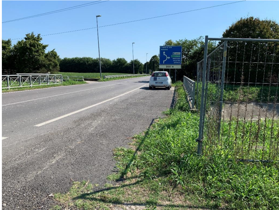
Vista n° 37 – Ponte stradale di attraversamento del canale scolmatore Mirano
