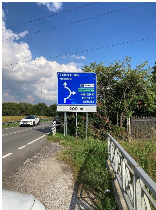
Vista n° 38 – Ponte stradale di attraversamento del canale scolmatore Mirano
