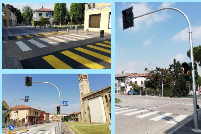
Da in alto a sx, in senso orario: un attraversamento di via Belvedere, il semaforo su via Chiesa, un attraversamento su via Caltana
