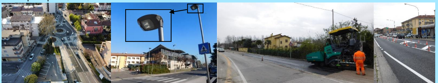
Rotonda e piattaforma di via Pestrino, attraversamento su via Vittoria, asfaltatura in via Luneo, rifacimento segnaletica orizzontale in via C. di Sala
