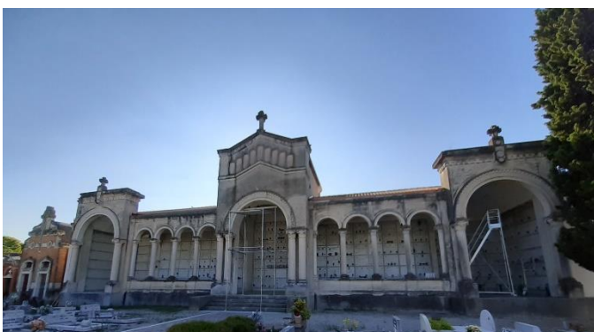
Il blocco loculi monumentale restaurato
