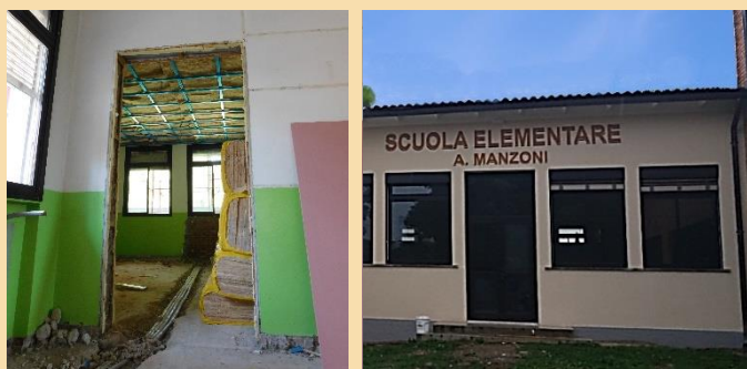
I lavori all'interno della scuola "Manzoni" di Ballò e l'esterno della stessa a lavori ultimati.
