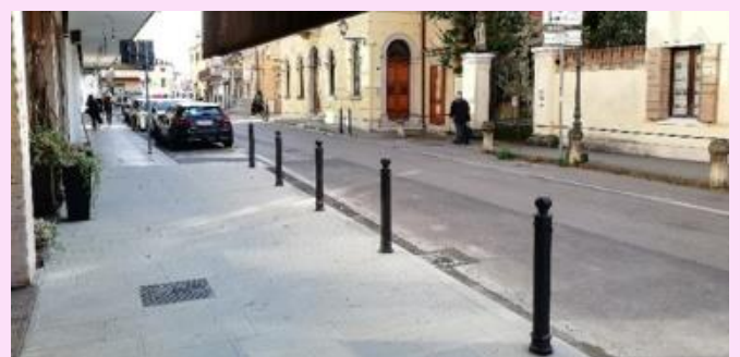
Il marciapiede di via Castellantico dopo i lavori
