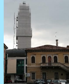
I lavori alla piscina e il cantiere del campanile
