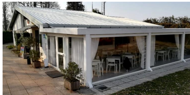
L'edificio del bar dopo la ristrutturazione
